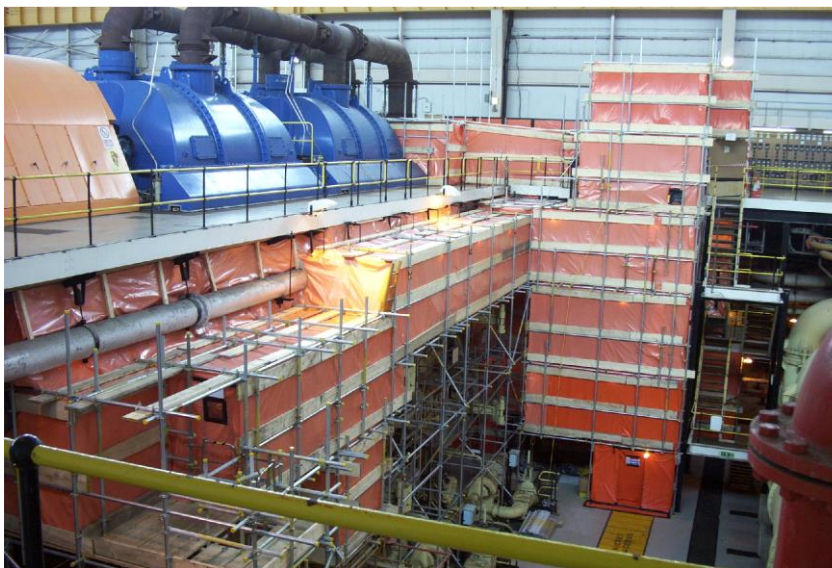
Ffotograff 3 - Tynnu Asbestos o'r Neuadd Dyrbinau yng Ngorsaf Bŵer Hinkley Point A
